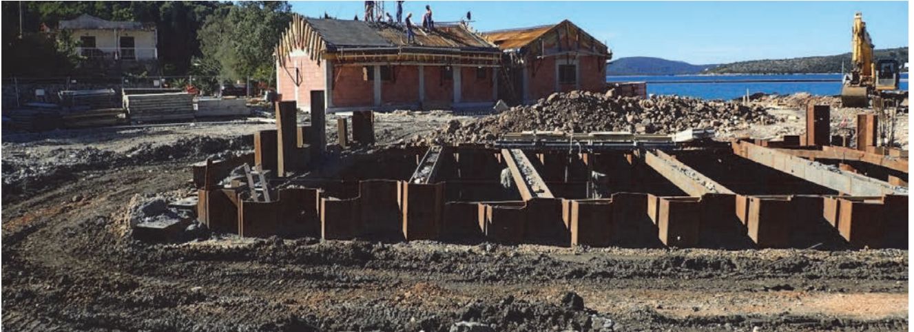
Izvedena zaštita građevinske jame na poziciji strojarnice bazena
