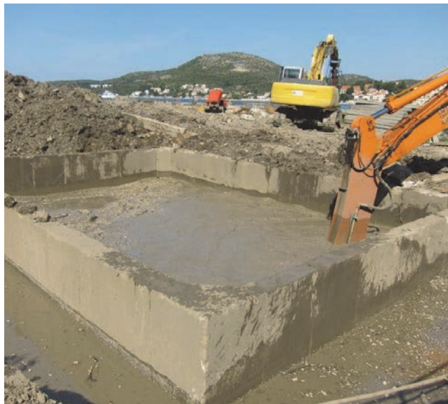
Iskop za potapanje II. faze
