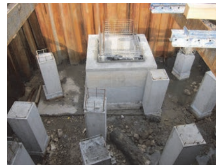
Stanje nakon sanacije CFA pilota i nakon postavljanja dubljega AB predgotovljenoga šahta
