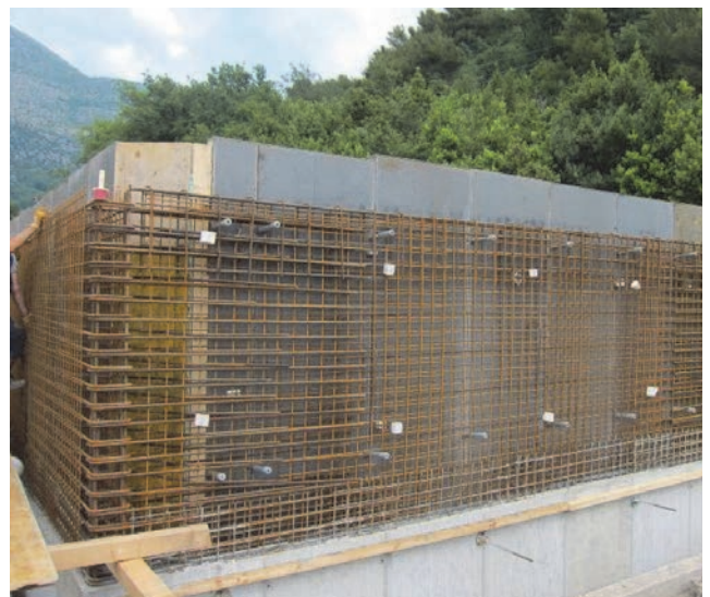
Izvedba AB zidova drugoga takta
