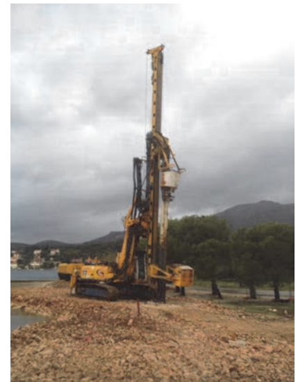
Izvedba šljunčanih stupnjaka
