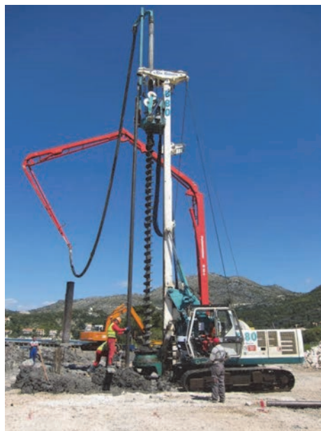
Bušenje CFA pilota
