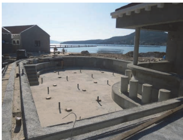
Izvedena konstrukcija vanjskoga bazena
