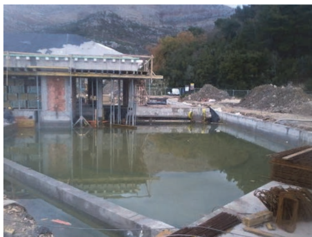
Izvedena zaštita bazena
