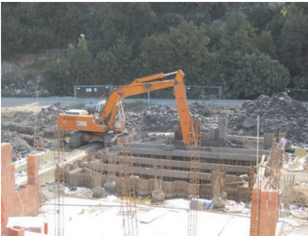
Iskop unutar zaštite građevinske jame
