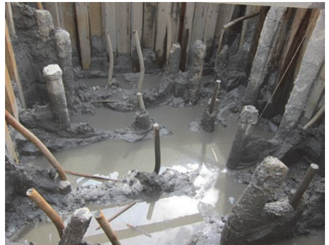
Stanje CFA pilota tijekom kopanja unutar građevinske jame
