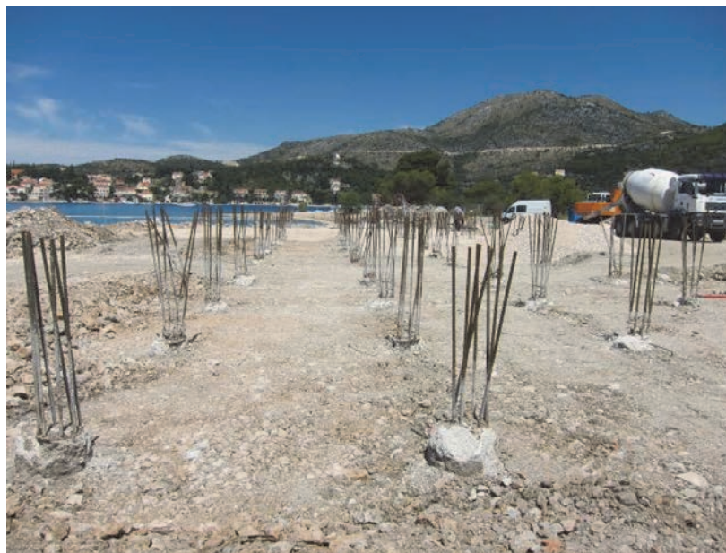
Izvedeni CFA piloti na poziciji temeljnih ploča
