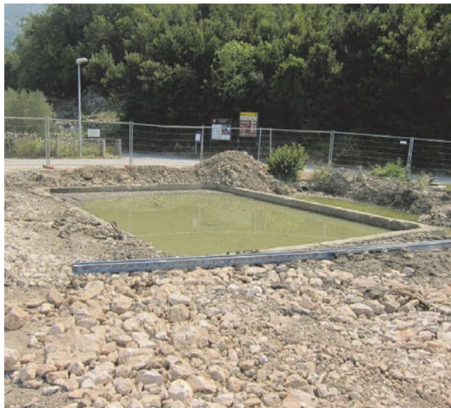
Keson/bunar potopljeni na projektiranu kotu
