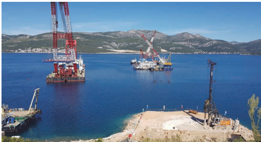
Pogled na gradilište mosta s pelješke strane
