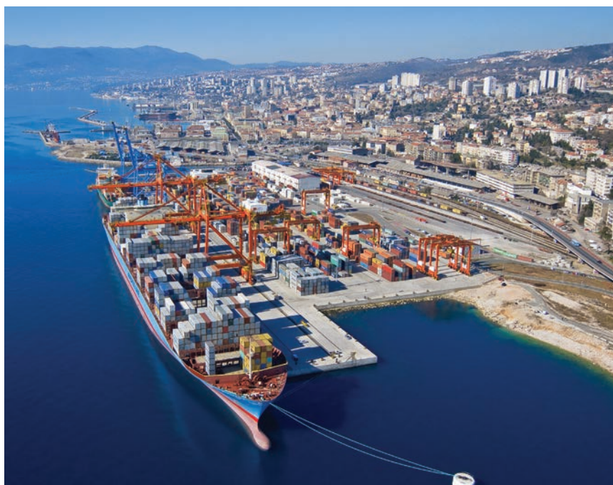
Izgradnja kontejnerskog terminala Luka Rijeka
