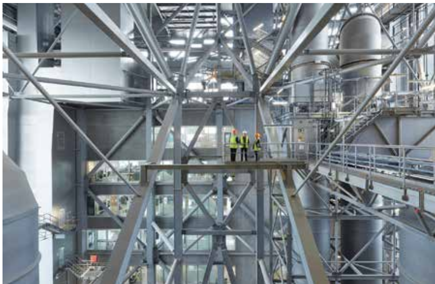
Pogled na unutrašnji dio spalionice otpada
