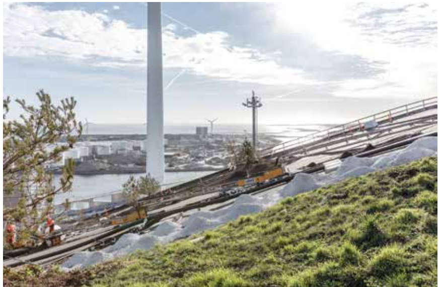
Detalj s gradilišta
