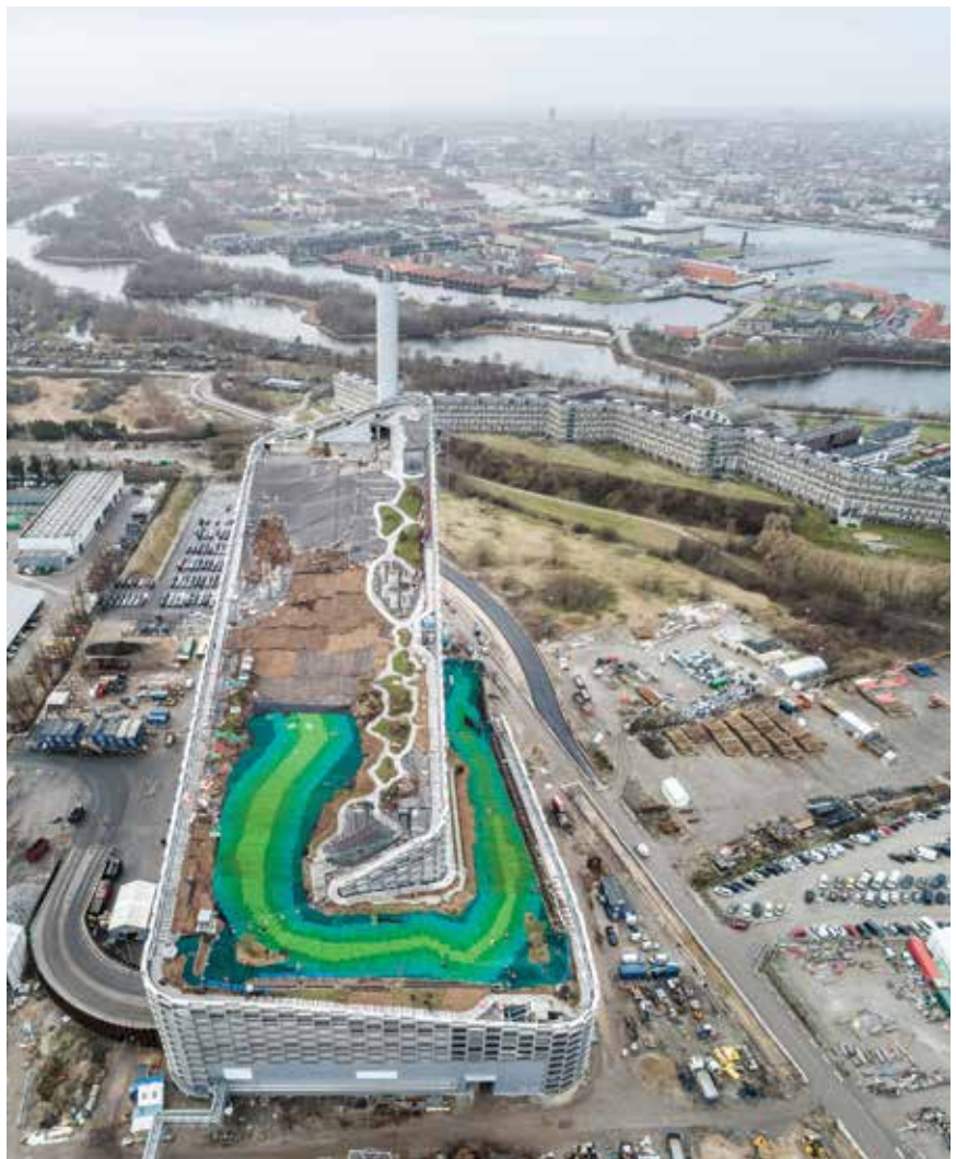
Gradilište snimljeno iz zraka
