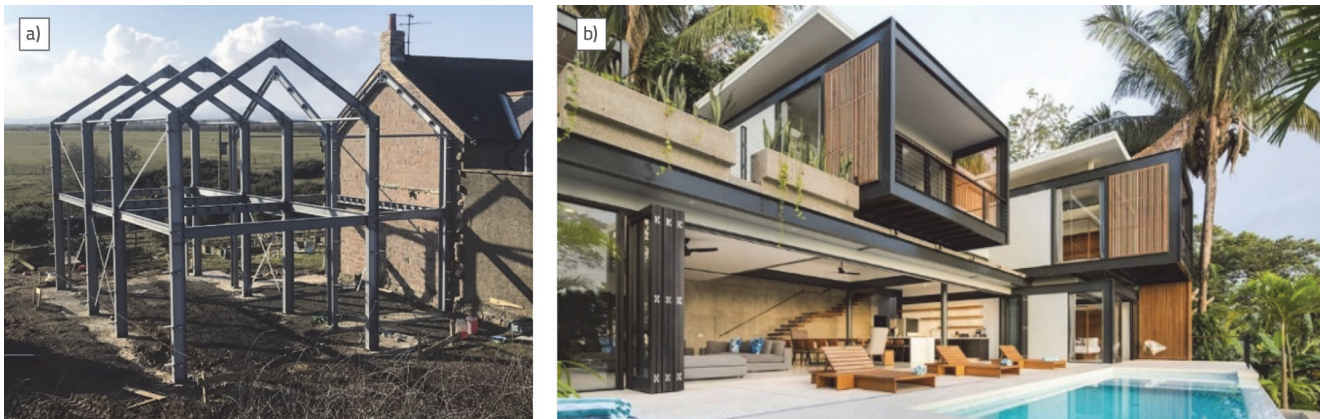
Slika 12. Primjeri okvirne gradnje obiteljskih kuća, a) Jednostavni, ponavljajući okviri [21], b) Costa Rica – urbana čelična vila [22]
