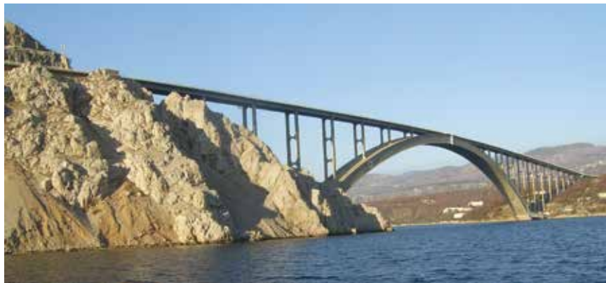
Završetak gradnje Krčkog mosta ulazi u povijest mostogradnje jer je tada bio dosegnut svjetski rekord u rasponu nosivoga armiranobetonskog luka
