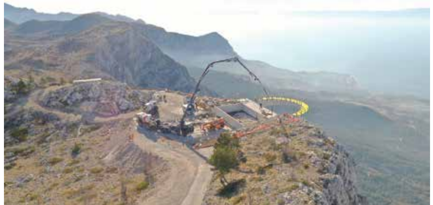
Detalj s gradilišta
