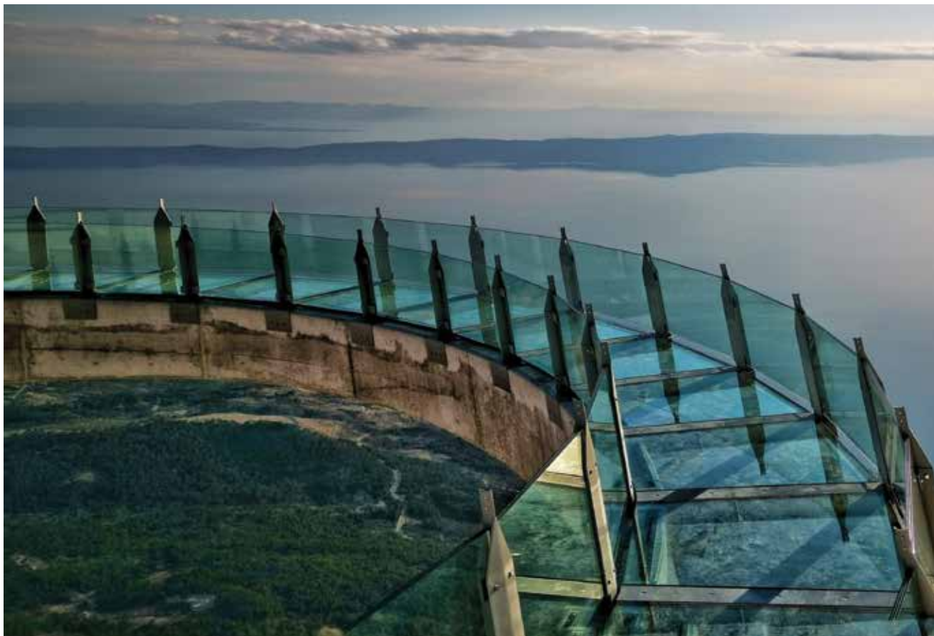
Staklene plohe oslanjanju se na čeličnu konstrukciju ( Fotografija: Dino Tomić)
