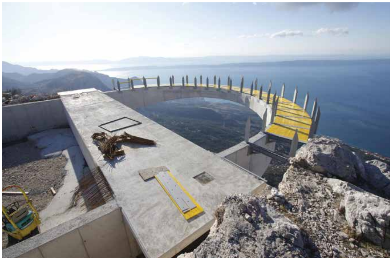
Temeljenje konstrukcije izvedeno je mikropilotima i geotehničkim sidrima
