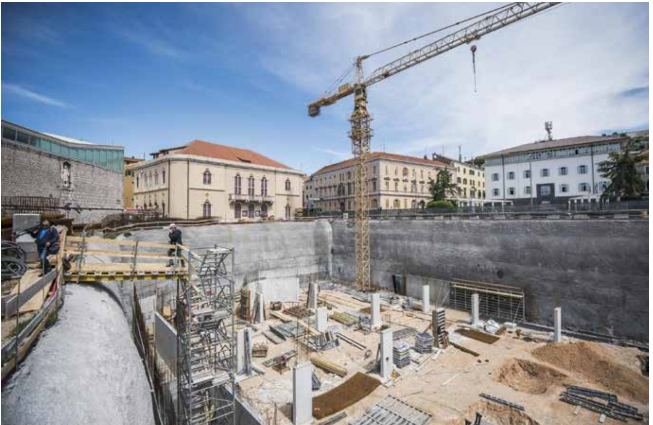
Gradnja podzemne garaže bila je vrlo složen tehnički zahvat u strogome središtu grada, neposredno uz zaštićena kulturna dobra i cestu
