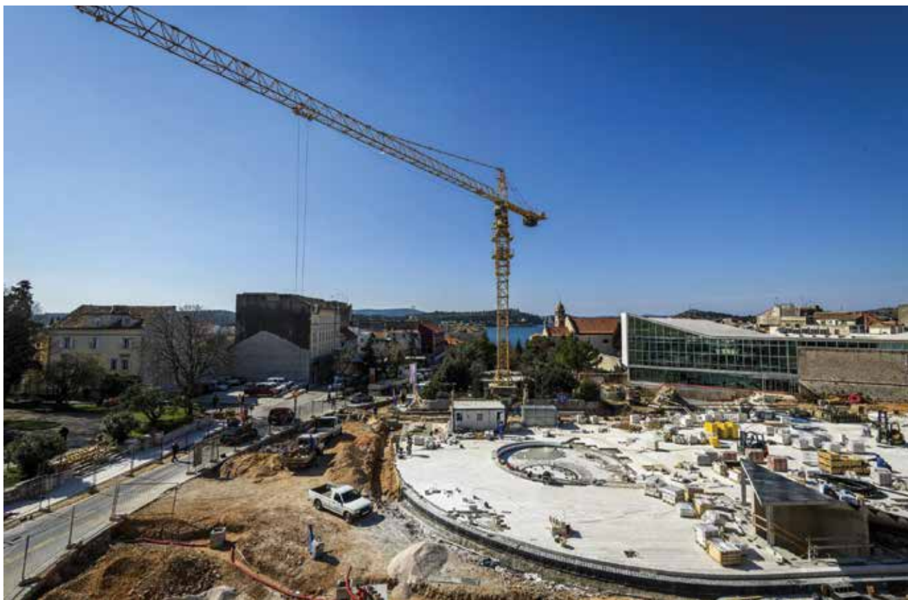
Građevinski radovi na uređenju gornjeg platoa trga (Foto: Nikša Stipaničev)
