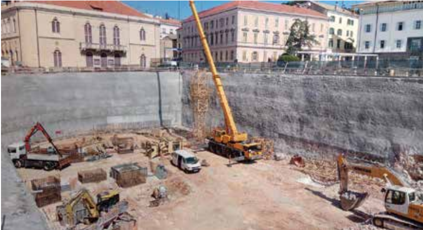
Detalj s gradilišta
