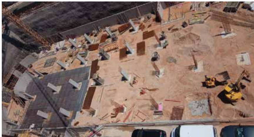
Armiranje stupova najniže etaže podzemne garaže (razina -3)
