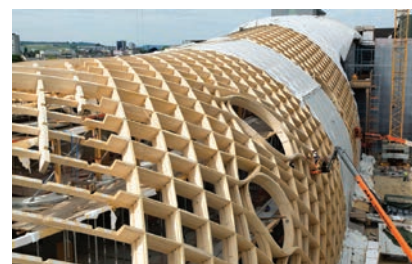
Detalj s gradilišta Swatch centra
