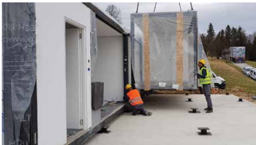
Izgradnja privremenog kontejnerskog naselja za smještaj stanovnika čije su kuće srušene u potresu
