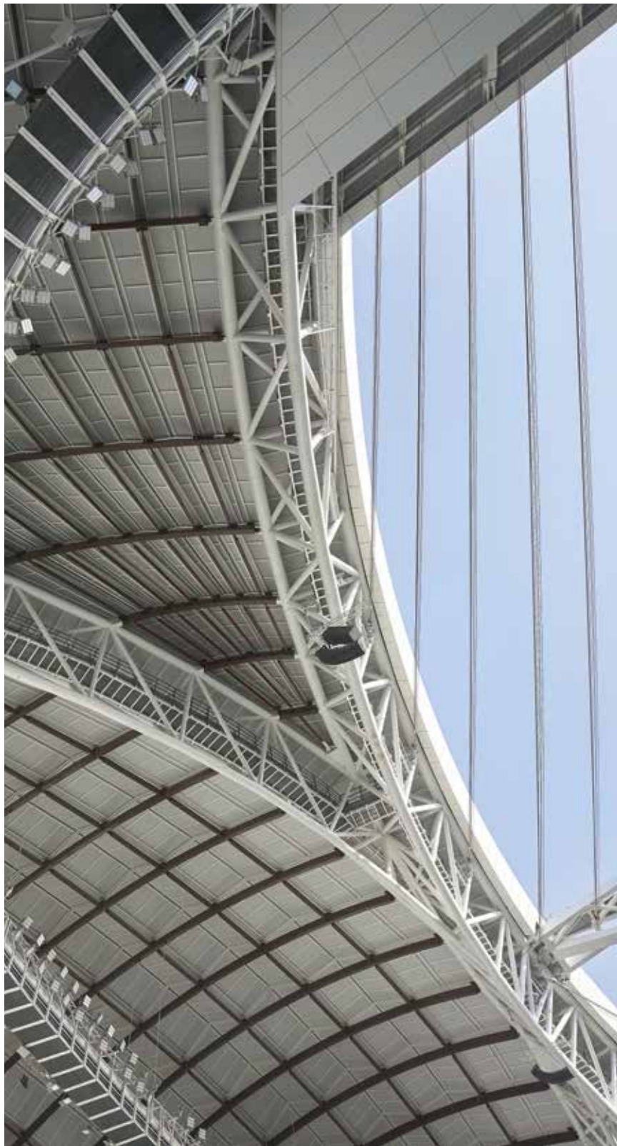
Čelična konstrukcija krovišta izmjenjuje se s drvenom koja pak podsjeća na skelet čamca
