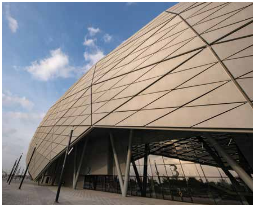
44 vertikalna V stupa dio su nosive konstrukcije Education City-a
