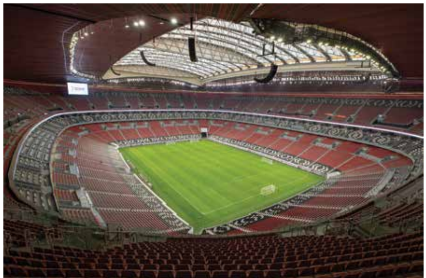
Donja razina gledališta stadiona šatora su montažne betonske tribine, a gornja je razina modularna čelična konstrukcija
