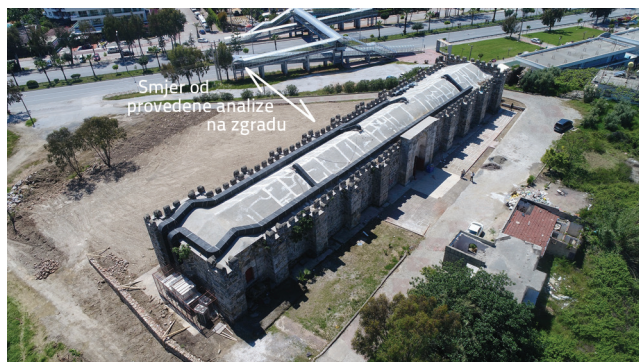
Slika 17. Analizirana zgrada (Şarapsa Han, Antalya – Turska) i smjer metode postupnog guranja provedene na modelima zgrade, (fotografija: autori)
