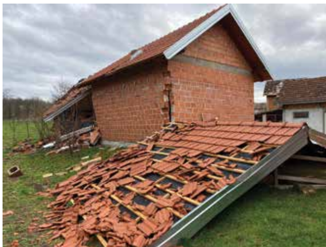
Većina oštećenih zgrada sagrađena je od nearmiranoga ziđa i opeka ( Autori: Ž. Jembrih, D. Milišić, N. Rebronja)
