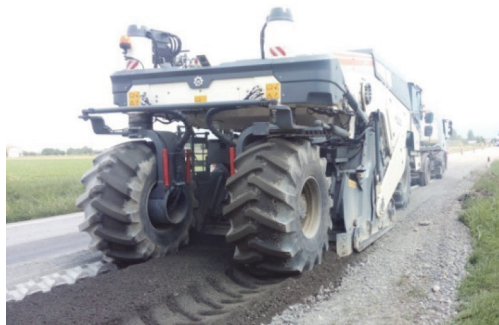
Slika 4. Cementna stabilizacija RAP-a koja koristi tehnologiju hladne reciklaže na mjestu gradnje
