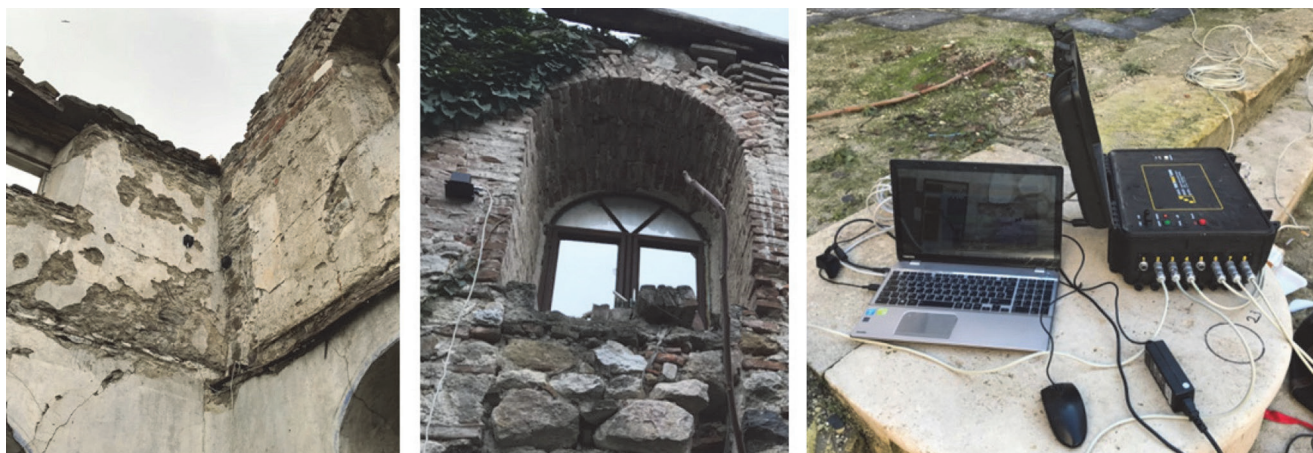
Slika 6. Vibracijska ispitivanja (postavljanje senzora i vibracijska oprema)
