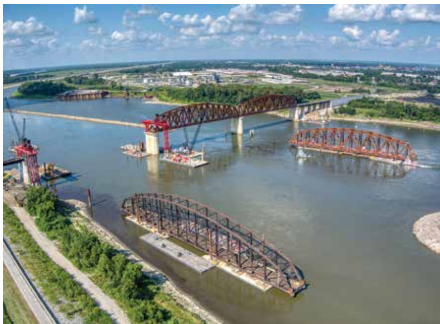
Pripreme za zamjenu starih sa novim rasponima
