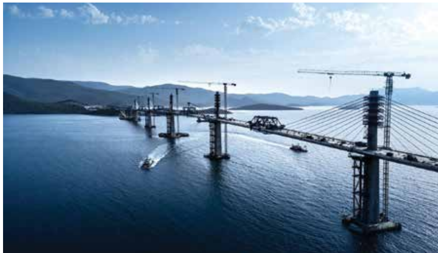
Detalj gradnje Pelješčkog mosta (Foto: Milan Šabić/ Pixell)
