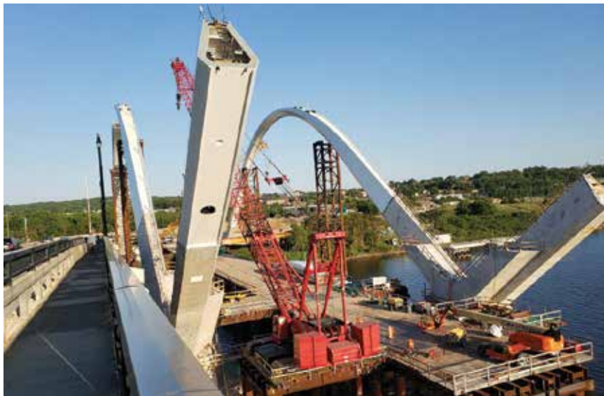
Detalj gradnje lukova na mostu
