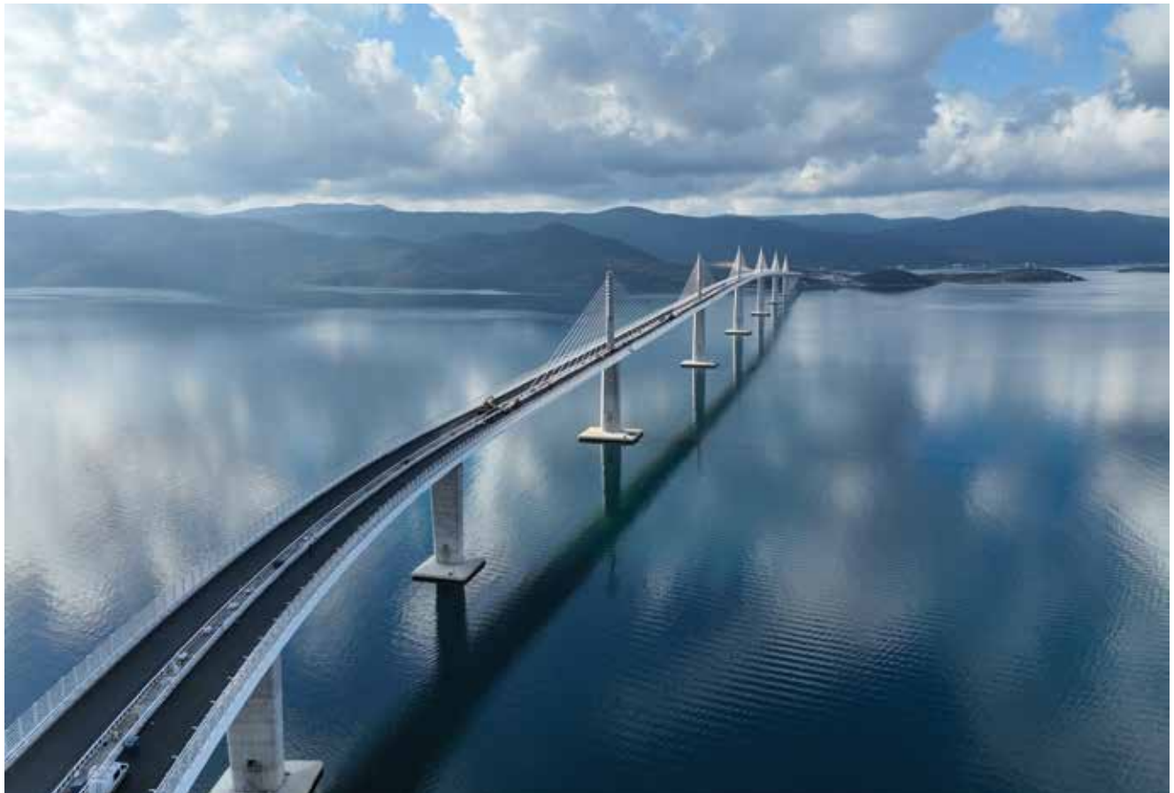
Pogled na Pelješki most (foto: Filip Kozina)
