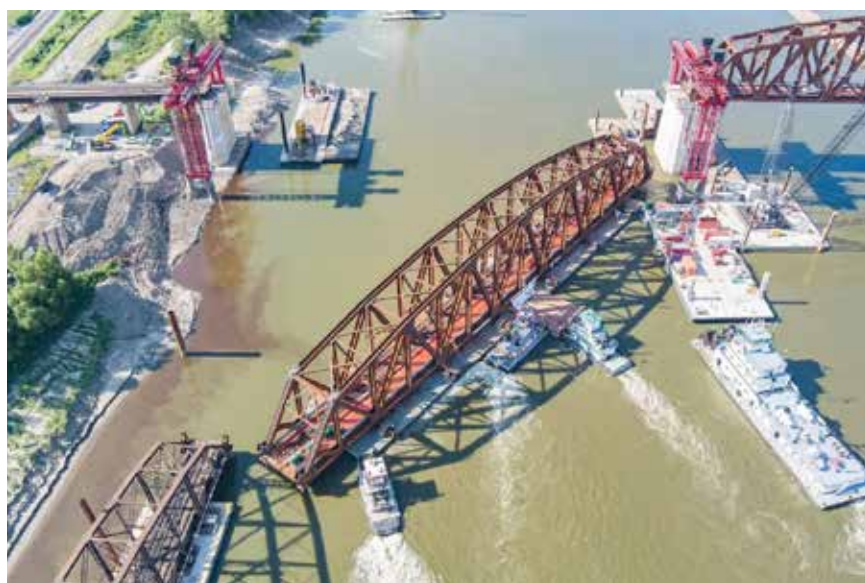
Uklanjanje starog raspona na mostu Merchants
