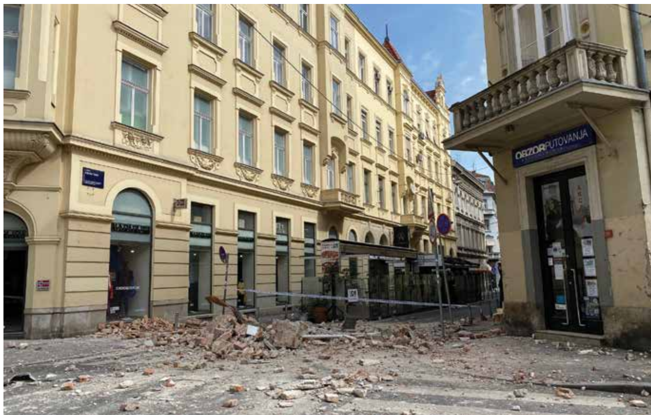
Planirana je provedba pilot-projekata za kružnu uporabu građevnog otpada iz zgrada kulturne baštine
