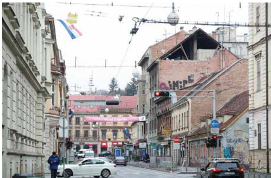
Bespovratnim sredstvima sufinancira se obnova zgrada oštećenih u potresu
