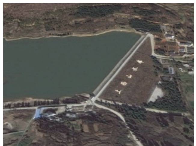
Slika 2. Stvarni pogled na projekt
