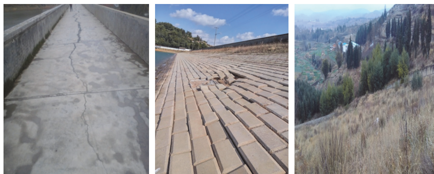
Slika 3. Sadašnje stanje vrha, prednje i stražnje strane zemljanih i kamenih brana
