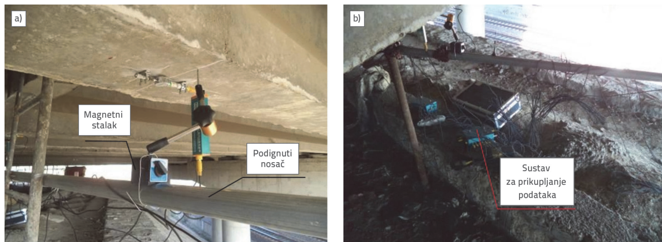
Slika 9. Postavke za mjerenje progiba ispod mosta: a) način postavljanja senzora za mjerenje pomaka; b) prikaz sustava za prikupljanje podataka
