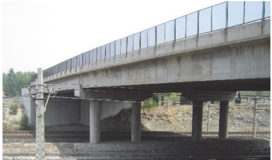
Slika 1. Most Ji-Jiao na kojem su provedena ispitivanja
