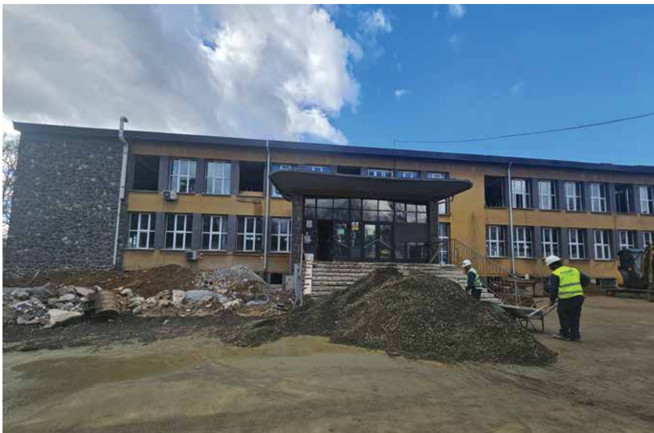
Gradilište snimljeno u ožujku 2025.
