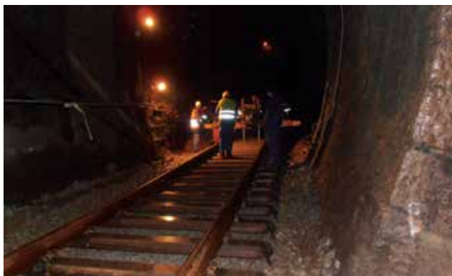
Strojno reguliranje kolosijeka u tunelu Rukavac
