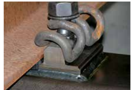
Način spajanja čeličnih pragova i tračnice
