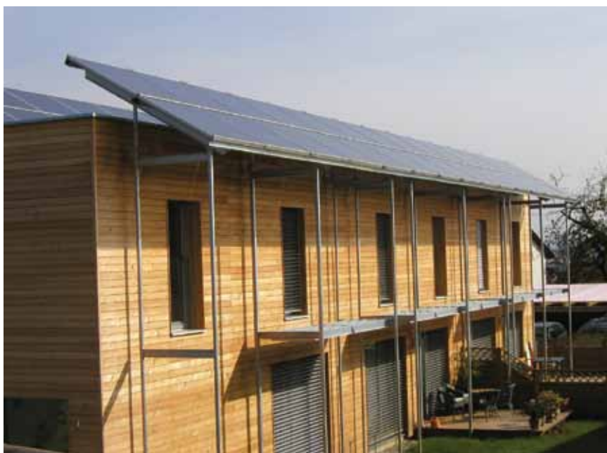
Termosolarni sustav ujedno služi i za zaštitu od sunca
