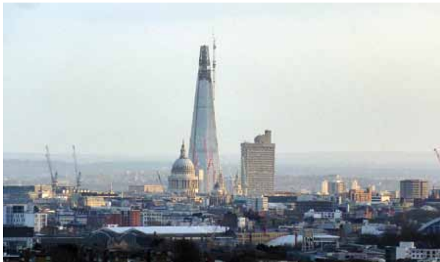
Pogled na gradilište sredinom 2011.
