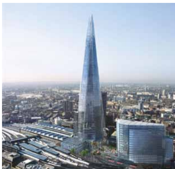
Završetak obloge nebodera, početak 2012.
