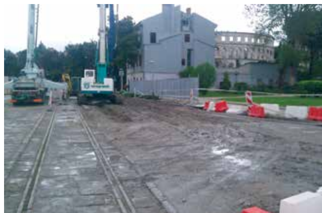
Početak gradnje kolektora na pulskoj Rivi
