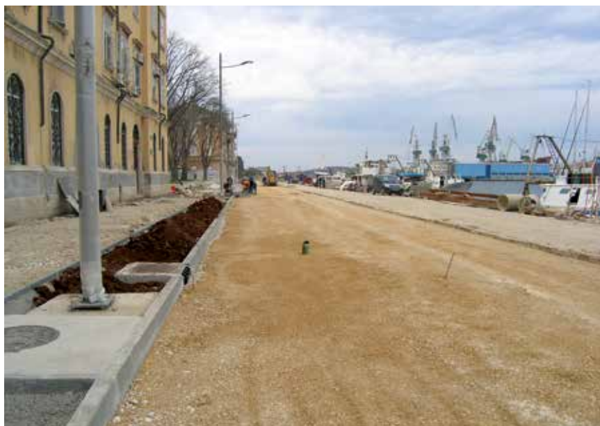
Pripreme za asfaltiranje na pulskoj Rivi
