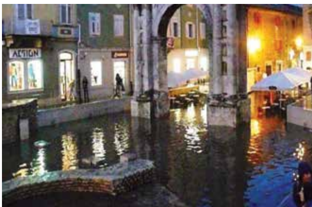
Mješoviti sustav odvodnje jedan je uzroka čestih poplava (detalj iz 2008.)
