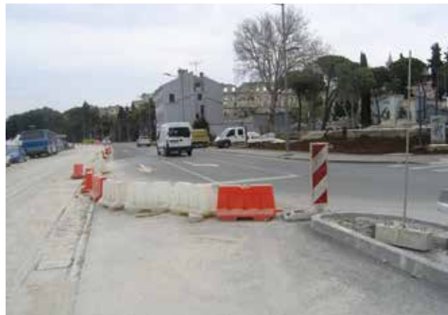
Dio gradilišta koji je pušten u promet
