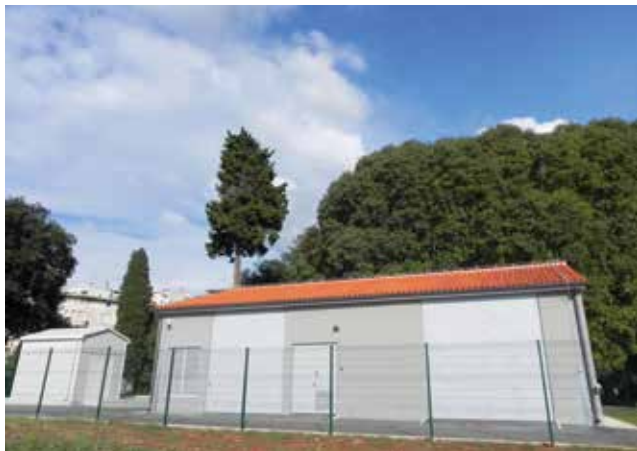
Zgrada crpne stanice Riviera
