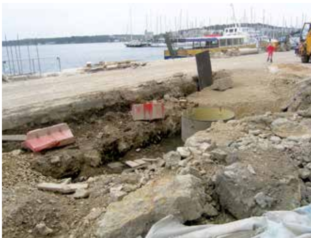
Detalj radova na Rivi
