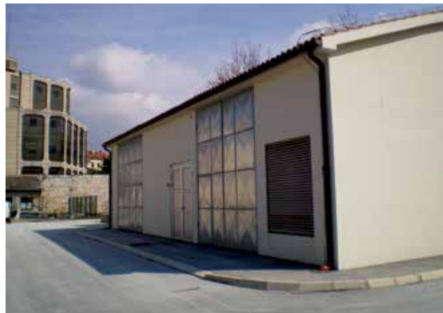
Zgrada crpne stanice Pošta-Uljanik
