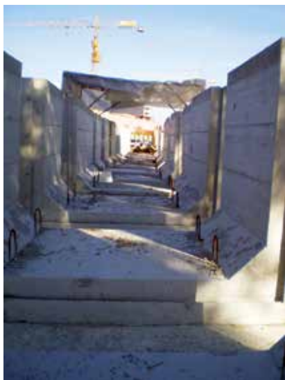
Radovi u građevnoj jami u Flaciusovoj ulici
