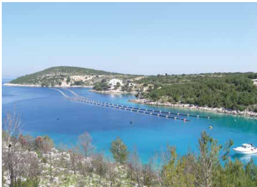
Cijevi na Hvaru prije ugradnje u podmorski ispust
