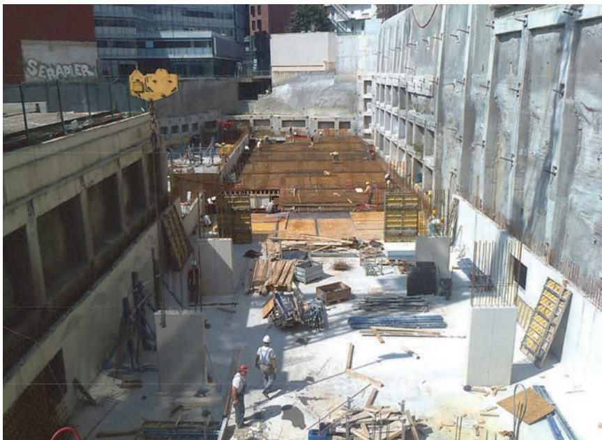
Druga faza gradnje garažnoga poslovno-stambenog kompleksa u Rijeci, iz izlaganja Zvonka Štimca
