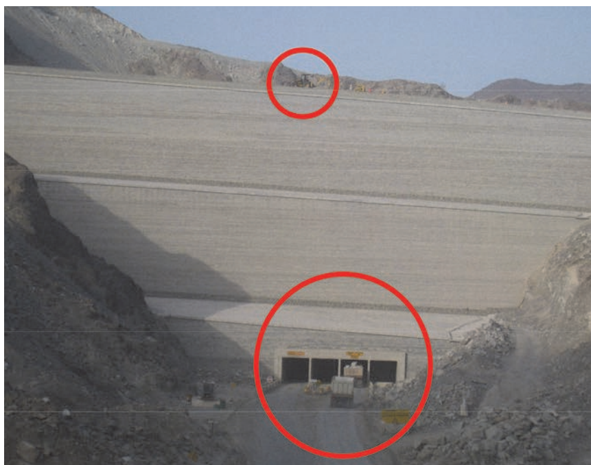
Fujairah Tensar zidovi, iz izlaganja Davida Kneifla
