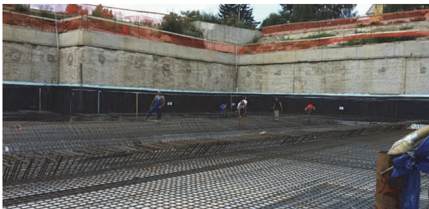
Prikaz zaštite građevne jame u Varaždinu iz izlaganja prof. dr. sc. Bože Solda
