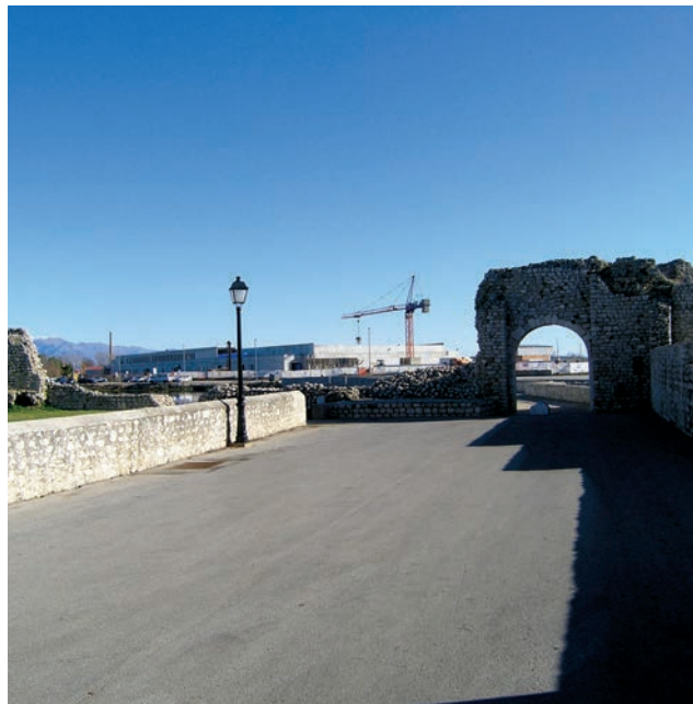
Gradilište mrijestilišta kroz ostatke utvrda
