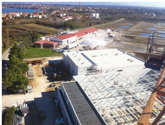
Detalj gradilišta i obližnje Solane (snimljeno s dizalice)
