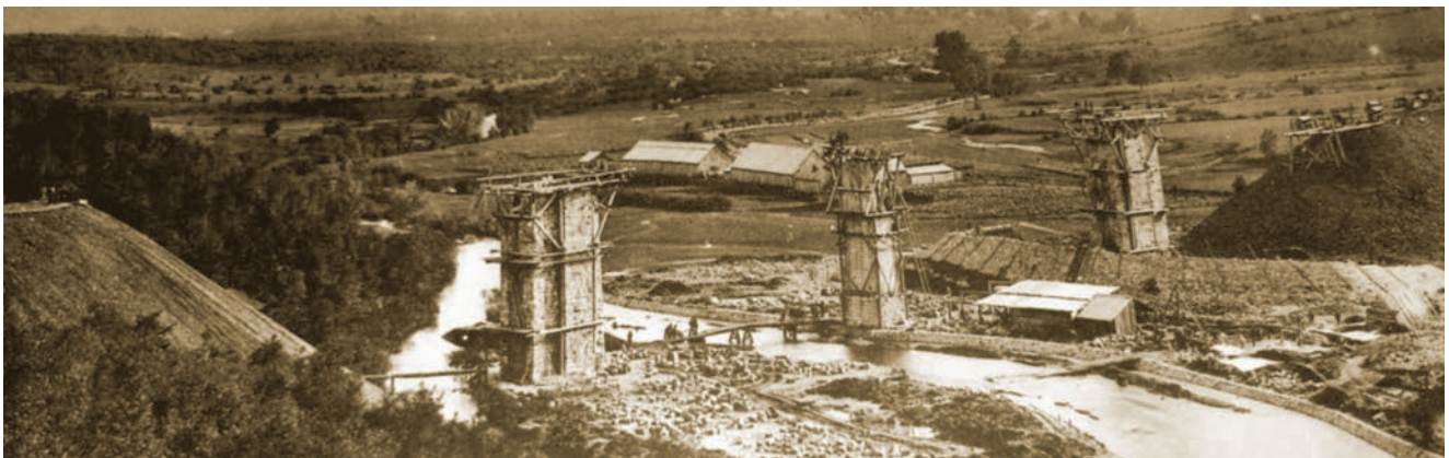
Gradnja prvoga željezničkog mosta preko rječice Ličanke
