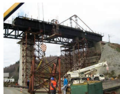
Početak ugradnje novoga mosta
