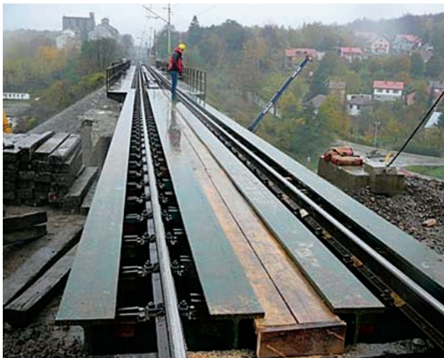
Gradnja provizornog mosta dugog 21 m
