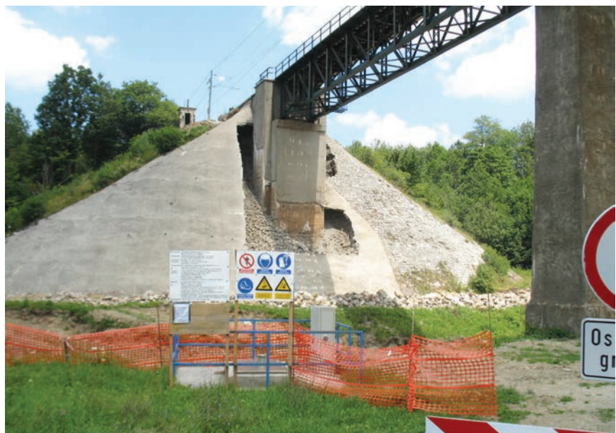
Početak radova na rekonstrukciji mosta
