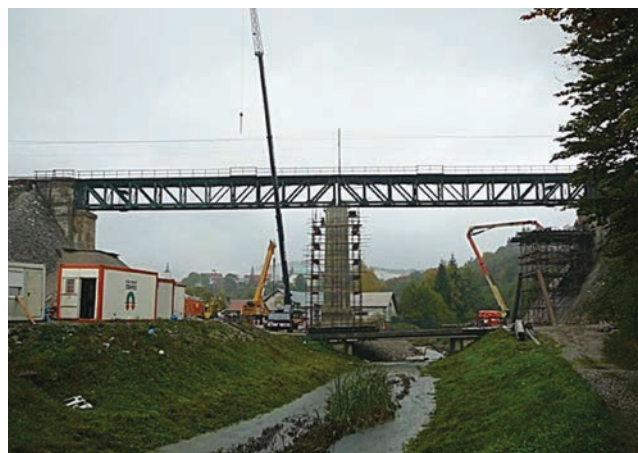
Ojačavanje upornjaka i stupa te zaštita vodotoka
