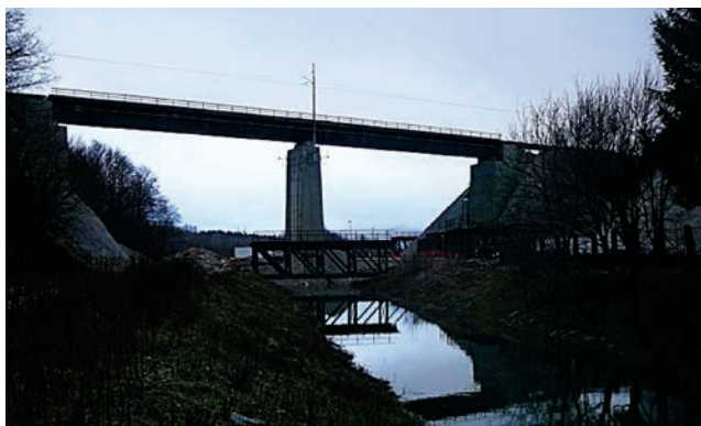
Pogled na novi most sa sandučastom čeličnom konstrukcijom
