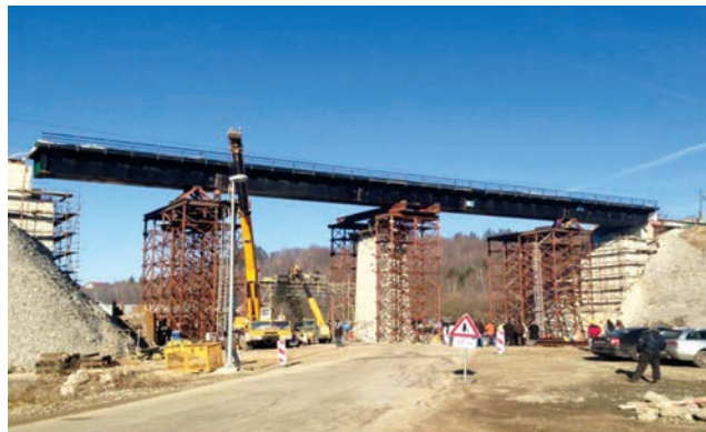
Naguravanje i ugradnja novoga mosta u jutarnjim satima
