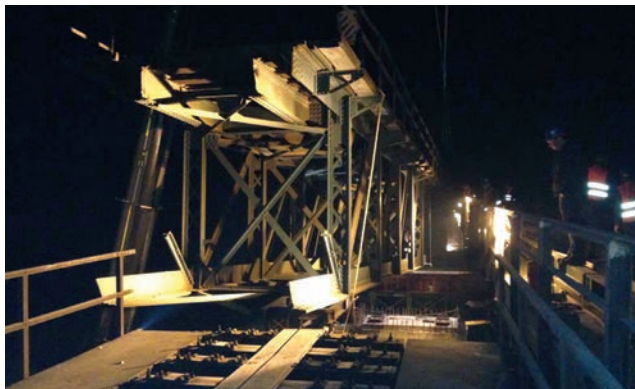
Radovi ugradnje tijekom noći
