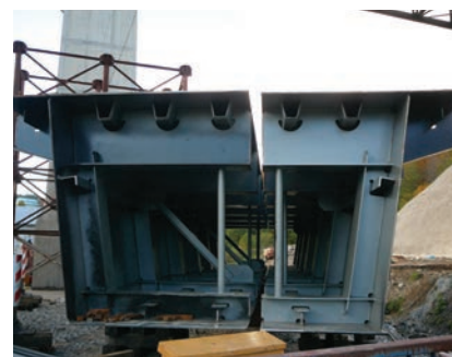
Spajanje raspolovljenih dijelova čelične konstrukcije
