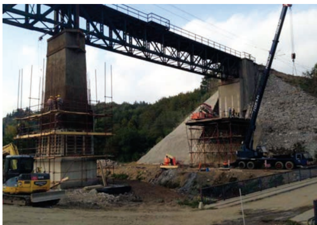
Ojačavanje stupa i upornjaka
