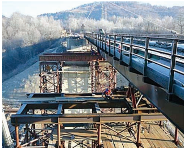
Demontirani dijelovi čelične rešetkaste konstrukcije staroga mosta
