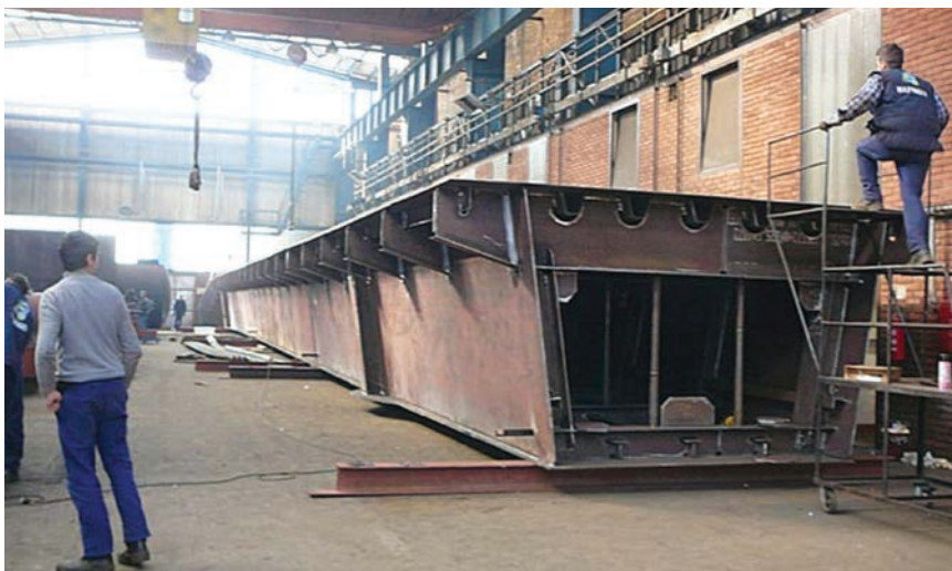
Izrada čelične konstrukcije u radionici u Slavonskom Brodu
