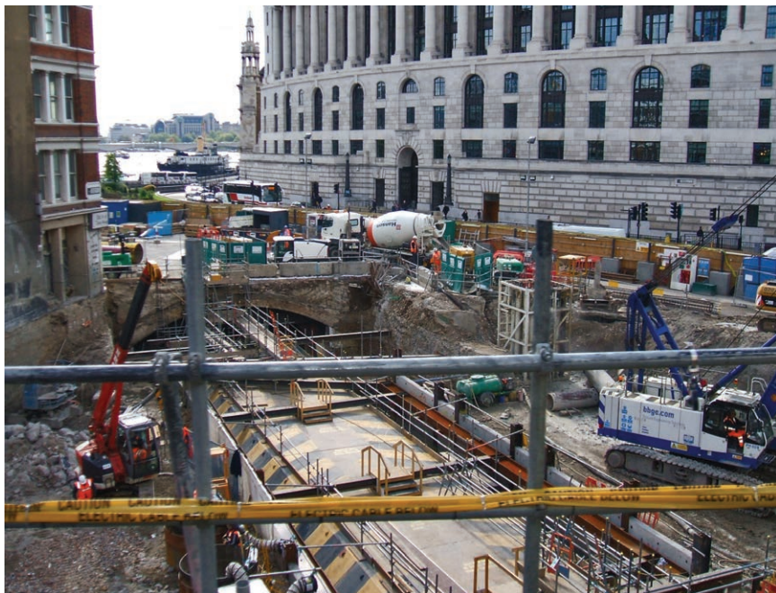
Ugovore o građenju nužno je nadopuniti klauzulama vezanim uz predstečaj (detalj jednoga našega velikoga infrastrukturnog zahvata)
