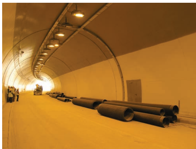
Tunel Klis Kosa u gradnji
