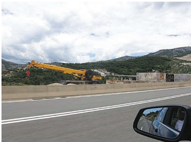
Detalj s gradilišta prije nekoliko godina
