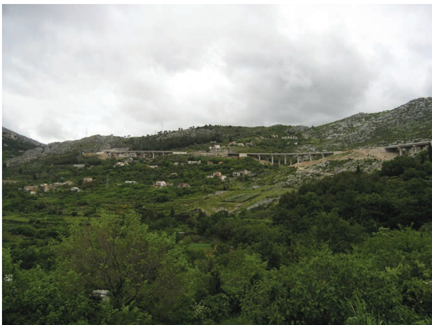
Vijadukti između tunela Klis Kosa i Klis Grlo
