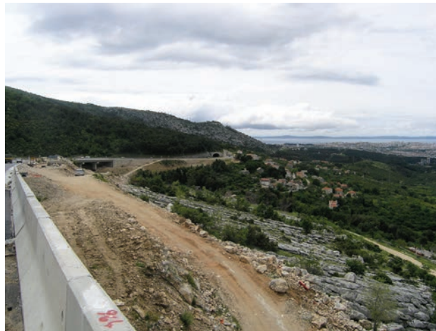
Dio trase iza sjevernog portala tunela Mačkovac
