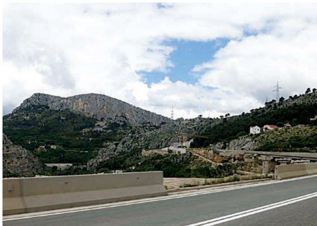
Detalj gradnje lijevog kolnika u početku radova
