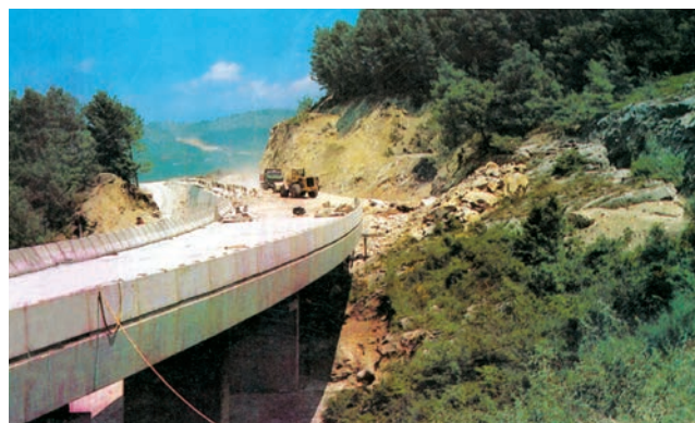
Jedan vijadukt u gradnji 1991. godine
