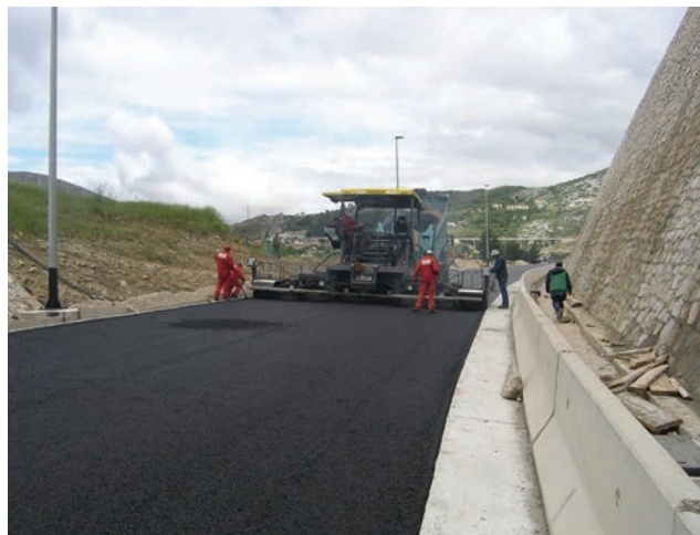
Asfaltiranje trase iza tunela Klis Kosa
