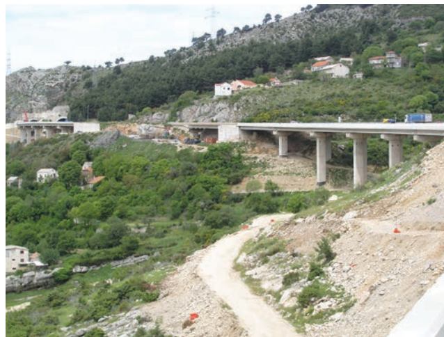
Prilaz tunelu Klis Kosa
