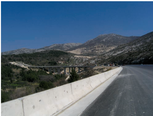
Gradnja lijevog kraka vijadukta Jamani
