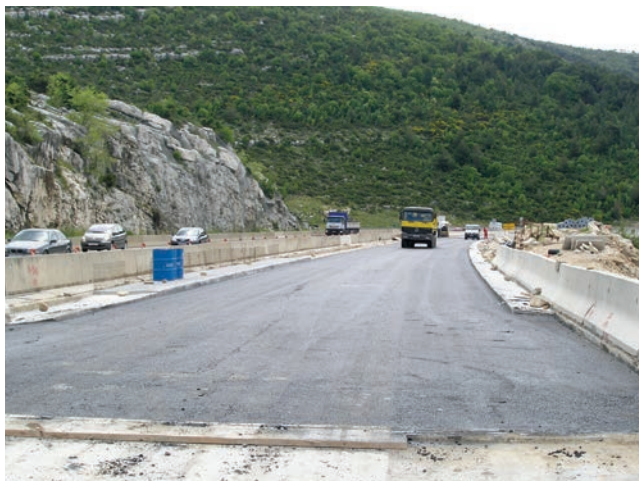
Gradnja vijadukta Bandalova kosa
