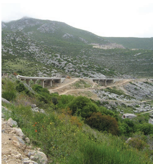
Gradilište vijadukata između tunela Klis Kosa i Klis Grlo
