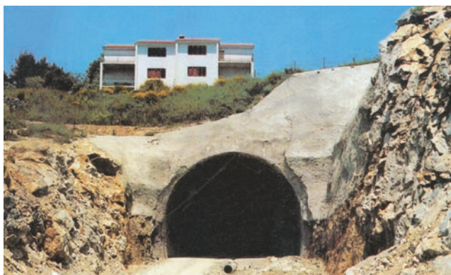
Portal jednog tunela u gradnji 1991. godine
