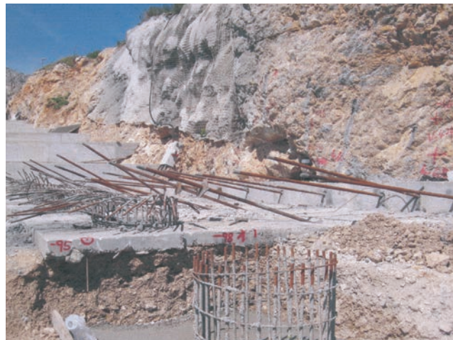
Armiranobetonski piloti na gradnji vijadukta Gornja Ozrna
