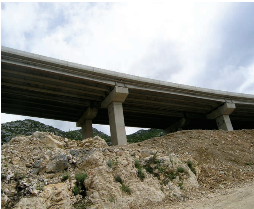
Podgled jednog vijadukta
