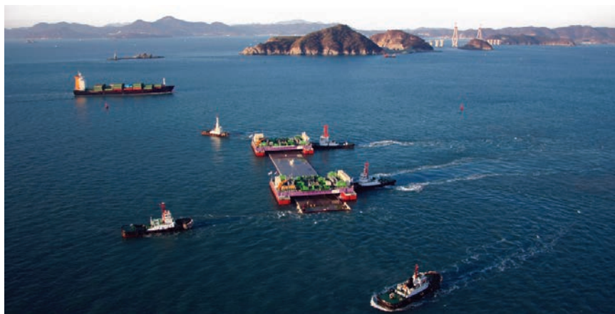
Dopremanje jedne sekcije tunela na gradilište
