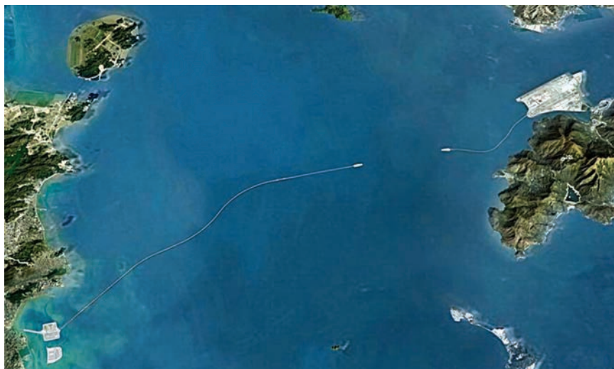
Gradilište snimljeno iz zraka
