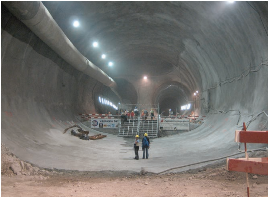
Detalj radova u tunelu
