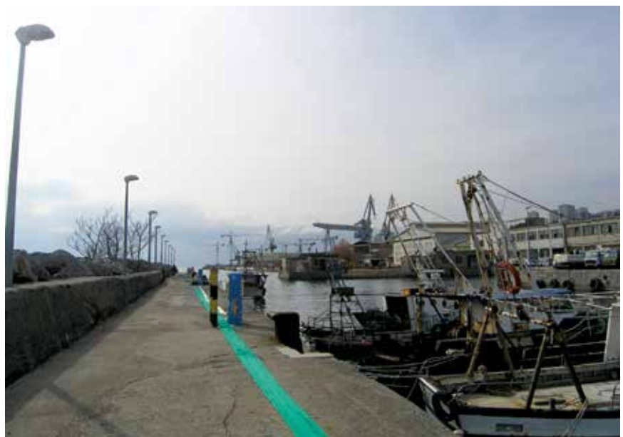
Dio brodogradilišta 3 maj snimljen iz Torpedova kompleksa
