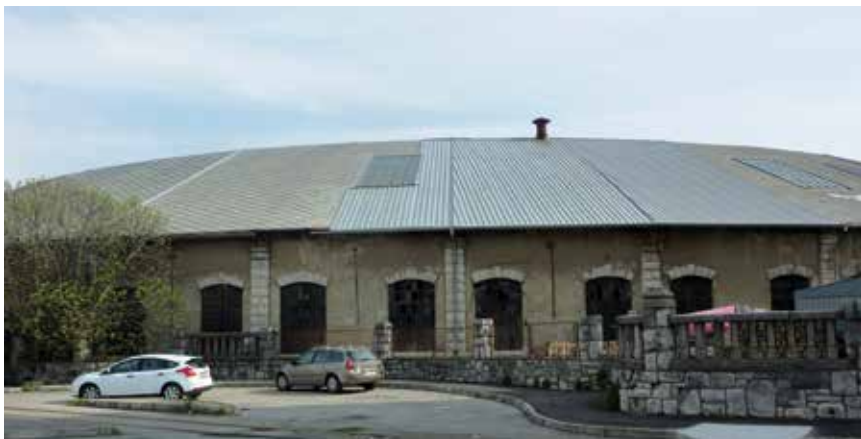
Ulično pročelje željezničke remire
