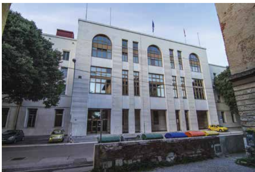
Bivša pogonska zgrada Ljuštionice riže i upravna zgrada Rafinerije nafte
